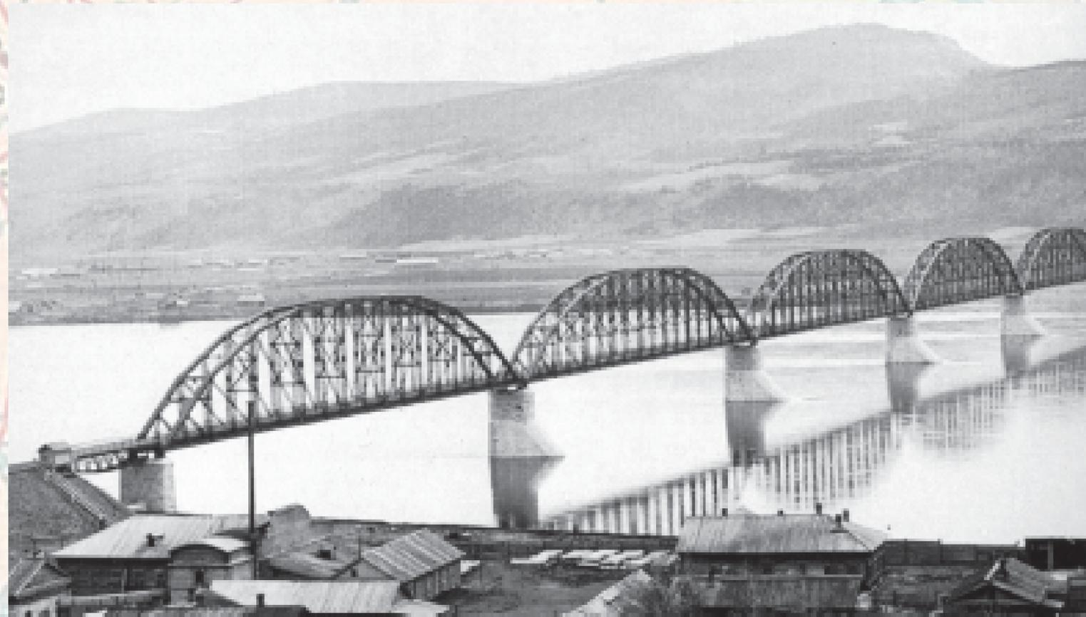
**На Среднесибирской железной дороге, как и на Западно-Сибирской, шла замена деревянных мостов на каменных опорах металлическими пролётами.**
