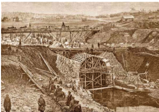
Рис. 3. Сооружение каменной водопропускной трубы вблизи станции Веребье на Николаевской железной дороге (1881)
